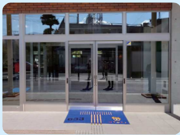
長崎県波佐見町新庁舎 正面入口
