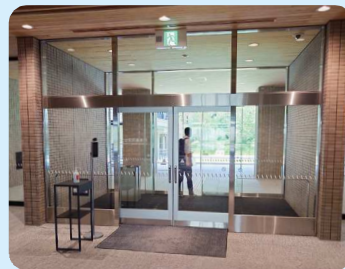
熊本県防災センター エントランス
